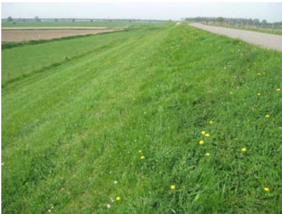
Figuur 3. Noordzijde van de winterdijk in Echteld op 29 april 2010. Aan de linkerzijde ligt de uiterwaard van de Waal, aan de rechterzijde (zuidzijde) ligt boomgaard nr. A6 (zie figuur 2). Aan beide zijden van de dijk is een plot met een lengte van 25 meter bemonsterd.
