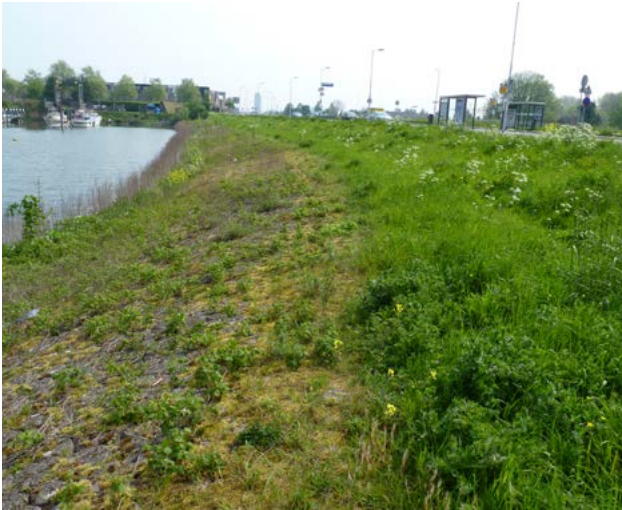
Figuur 31 Jachthaven IJsselmonde, 25 april 2014. De onderste helft van het talud is geplaveid met stenen.
