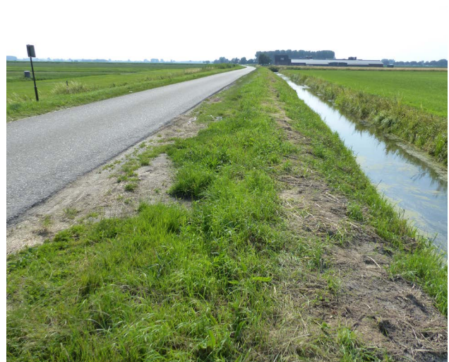
Figuur 9 Vorstweg, 5 juli 2017. De berm is geklepeld en behalve een dik pak maaisel ligt er ook bagger uit de sloot.
