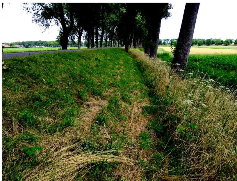
Figuur 32 Het maaisel is hier niet afgevoerd, waardoor de vegetatie verstikt wordt door een dikke laag verdord maaisel. Wel is er gefaseerd gemaaid. Schenkeldijk, 7 juli 2018 (foto Linde Slikboer).
