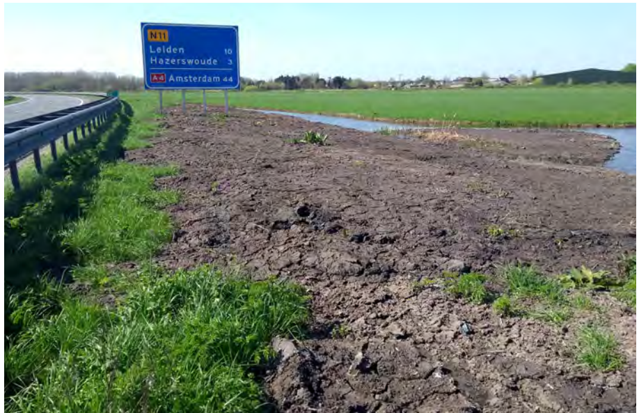
Figuur 9 Bermtraject Links 8,4-8,7 op 18 april 2018. Over een groot gedeelte is bagger uit de sloot uitgestort.
