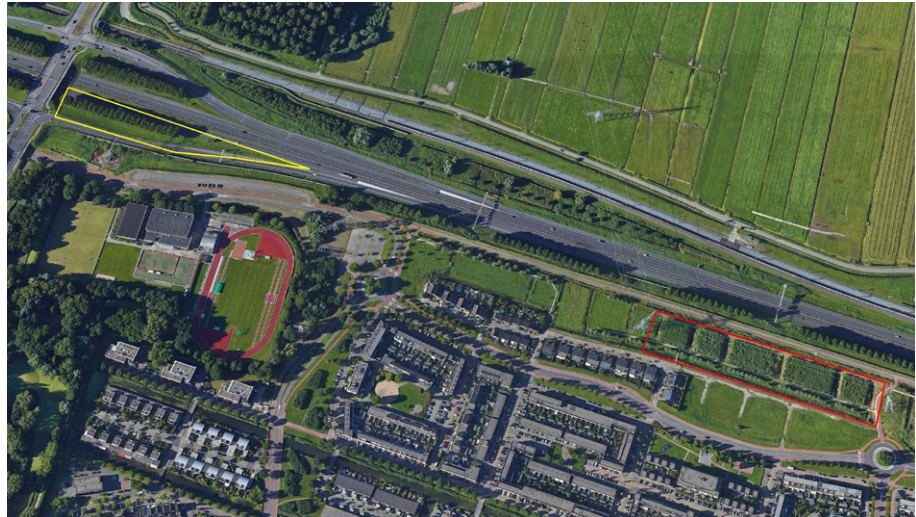
Figuur 22 Talud A15 en aangeplant bos oostzijde Geel – talud A15, Rood – aangeplant bos oostzijde. Bron Google Earth.
