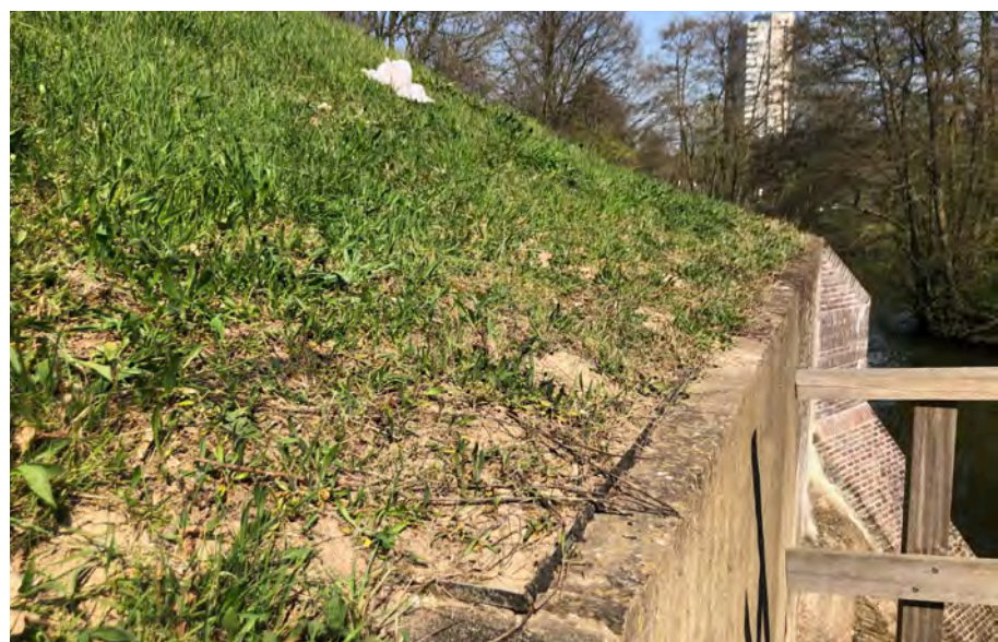
Figuur 50 Onderste deel van het talud boven de kademuur van Lunet II, waar zich de nestaggregatie bevindt. De schaarsbegroeide plekken zijn duidelijk zichtbaar.
